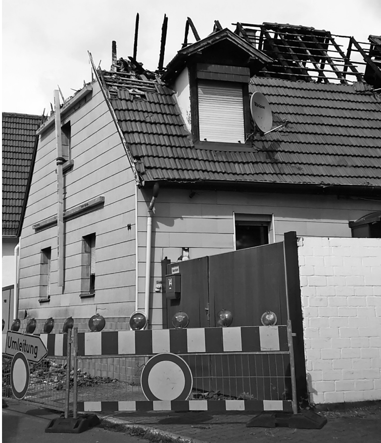
Abb. 5: Haus im Raum Heidelberg nach Blitzeinschlag am 28.5.2016
